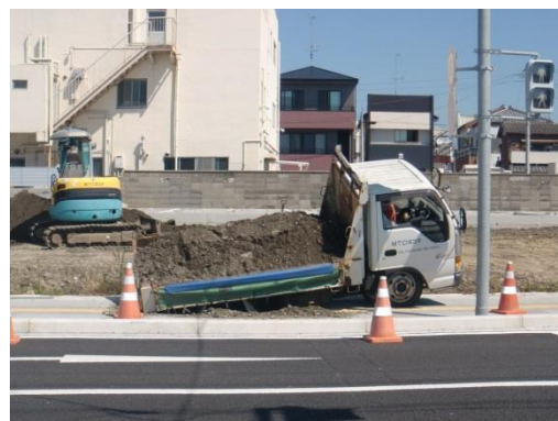
老朽化した管きよによる陥没事故の状況（小名浜地区）
