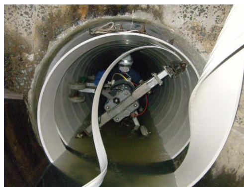
管更正*の工事現場写真
