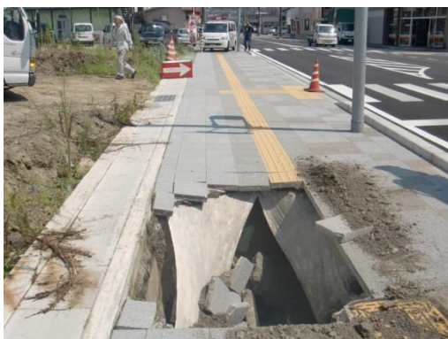
老朽化した管きよによる陥没事故の状況（小名浜地区）
