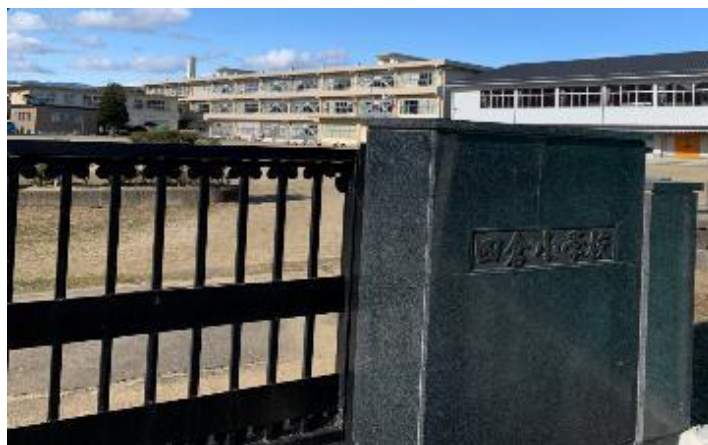
(四倉小学校の外観)
