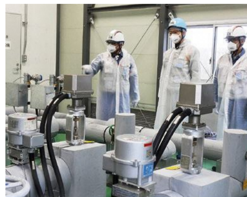
緊急遮断弁を確認する様子
