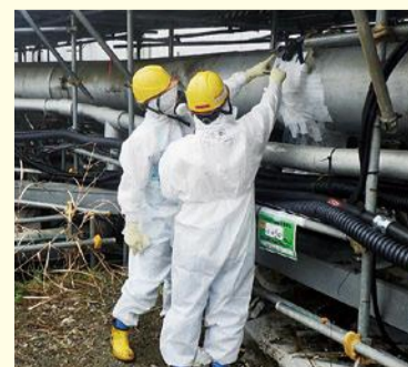
現地確認を行う様子
