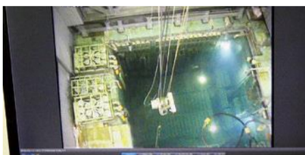
使用済燃料プールのクレーンの様子
