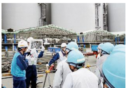
第8回 安全確保技術検討会(現場調査)の様子(R5.3.23開催)
