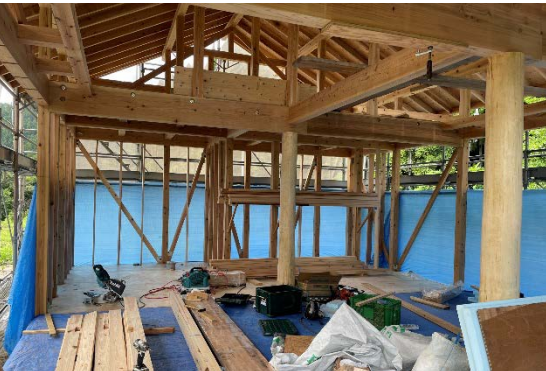
既に屋根を葺いてもらい、筋交い・間柱を付ける作業に取り掛かってます。拠点を不在にしていることがありますので、お越しいただく際は、下條 (080-6658-9578) までご連絡ください。
