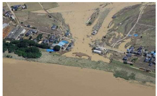
堤防決壊による家屋の流失(鬼怒川)
