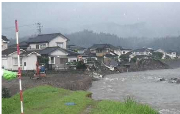
河岸侵食による家屋の倒壊(花月川)
