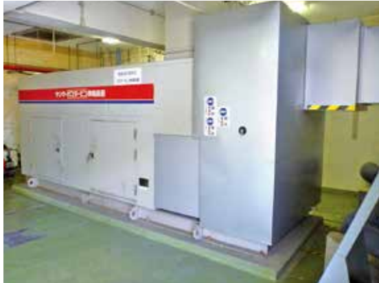
上野原浄水場の非常用自家発電設備
