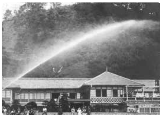
四倉町での放水試験
