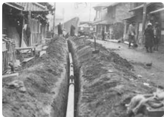
昭和12年頃の配水管布設
