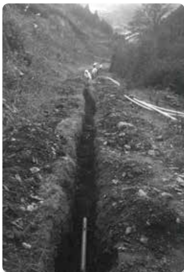
佐倉簡易水道導水管布設
