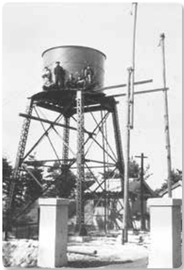
鎌田山浄水場附属高架水槽
