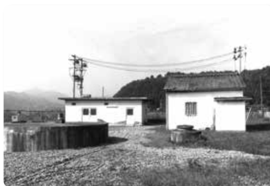
法田ポンプ場
