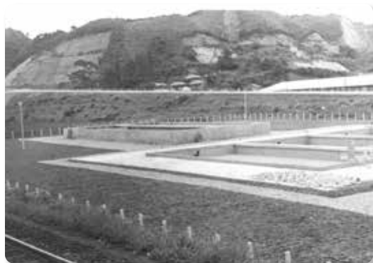
久之浜浄水場
