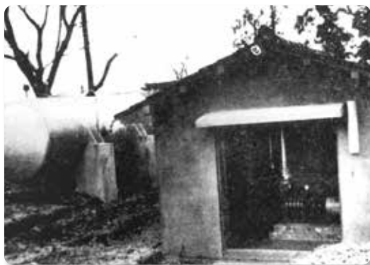
上野原浄水場内の好間浄水ポンプ場
