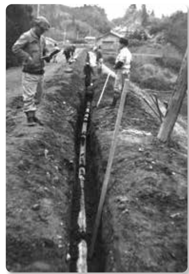
川部簡易水道配水管布設
