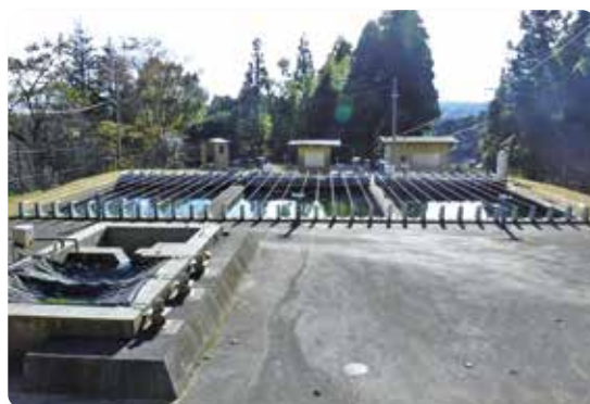
鷹ノ巣浄水場
