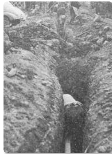
配水管布設工事
