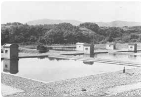
上野原浄水場ろ過池【平町上水道創設当時】
