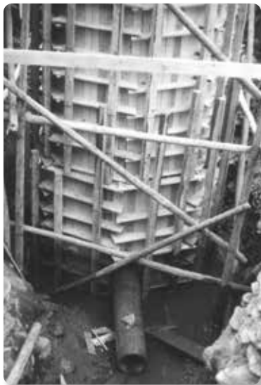
下滝簡易水道 水源地有孔ヒューム管埋設工事
