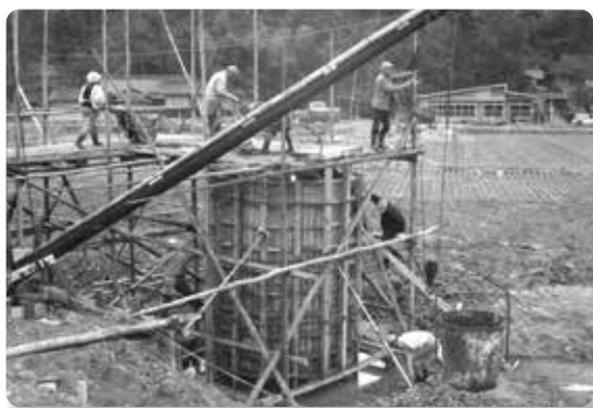
昭和45年薬王寺簡易水道 ポンプ場築造
