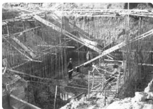
昭和11年頃の栗木作浄水場建設
