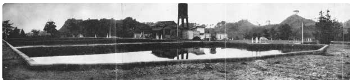
小名浜浄水場緩速ろ過池
