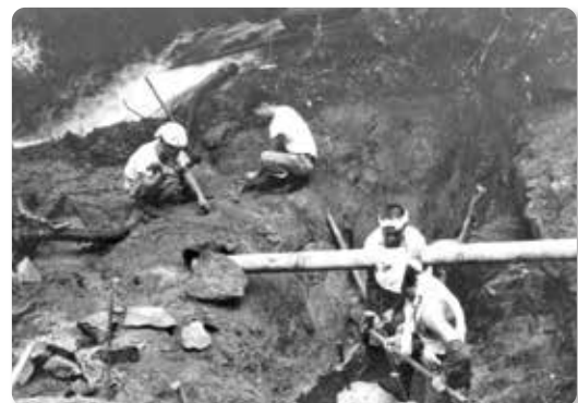
川前浄水場水源工事
