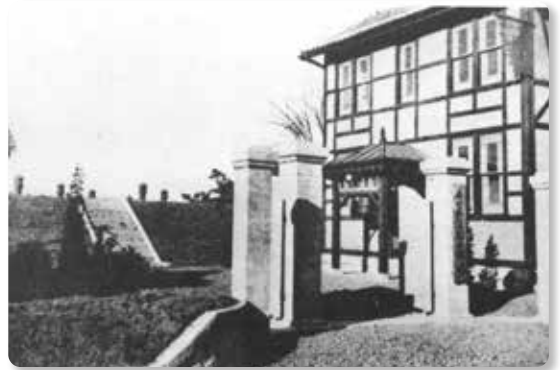
八幡小路配水場【平町上水道創設当時】
