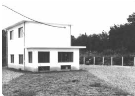
小川水源ポンプ場
