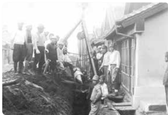
小名浜町上水道配水管敷設
