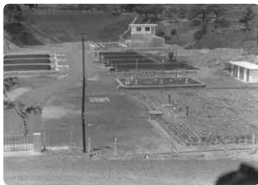
昭和41年増設工事後の栗木作浄水場
