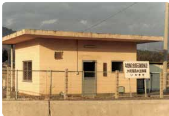
昭和48年大和簡易水道ポンプ場
