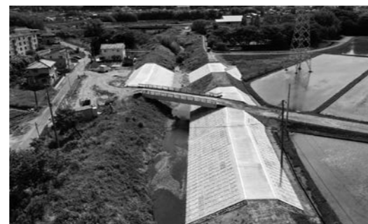
護岸整備が行われていく市内の河川
