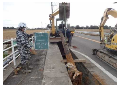
配水管の改良工事の様子
