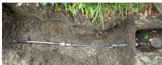
鉛製給水管の布設替えの状況 上：施工前（鉛製管）下：施工後（ビニル管）
