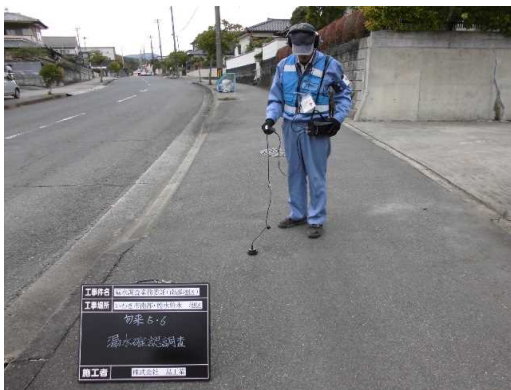
漏水調査の様子①（路面音聴調査）
