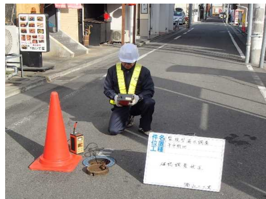
漏水調査の様子②（管路音圧監視システム）
