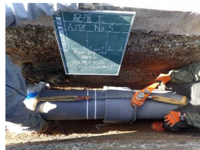
耐震管(GX形)布設の様子
