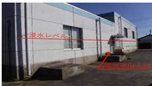
電気室出入口付近浸水レベル
