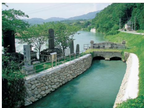
小川江筋取水口
