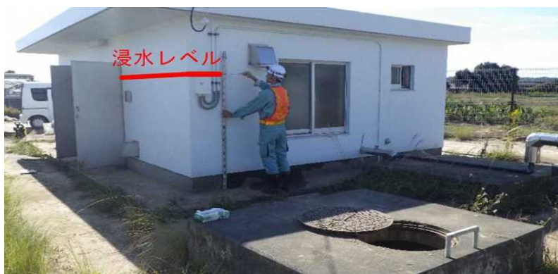
平窪第2ポンプ場建屋外浸水レベル
