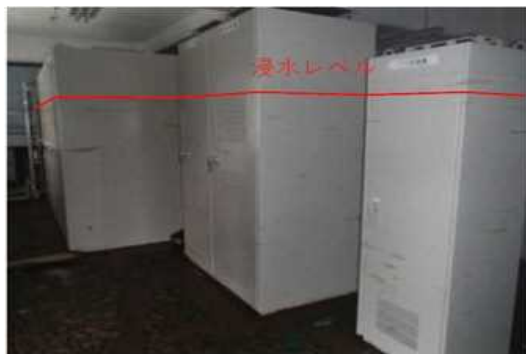
電気室内浸水レベル
