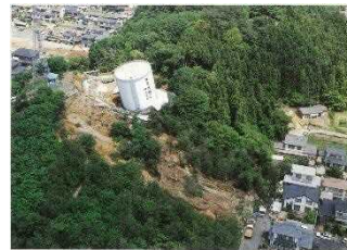
図 土砂流出災害に伴う常磐配水池の被害状況
