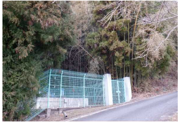
図 下ヶ屋敷調整池 現地調査写真
