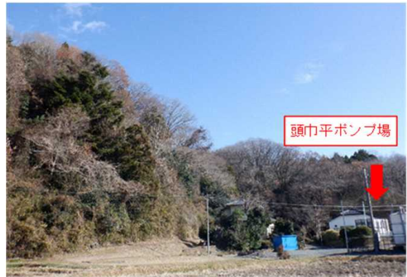
図 頭巾平ポンプ場 現地調査写真
