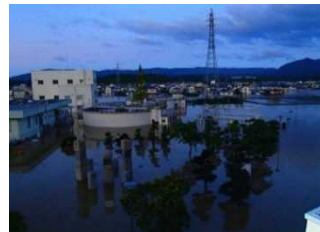
図 令和元年東日本台風における平浄水場の浸水被害状況
