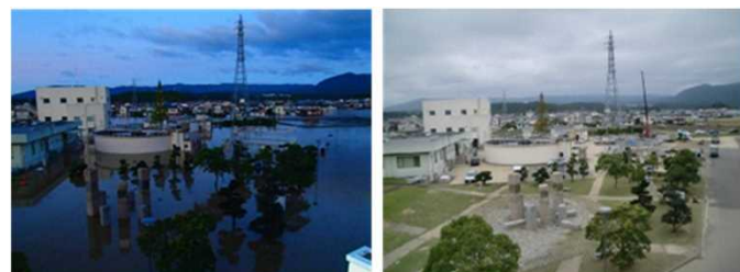
濃縮槽、脱水機棟、排水池(浸水深 地盤から約125cm)
