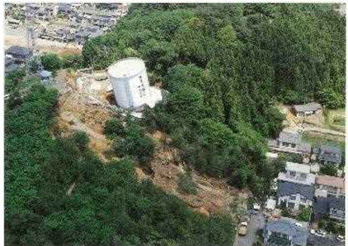
図 平成9年の土砂流出災害に伴う常磐配水池の被害状況
