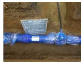
老朽管を撤去し新たな管を布設している様子
