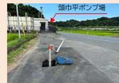
消火栓から給水を可能とした様子
