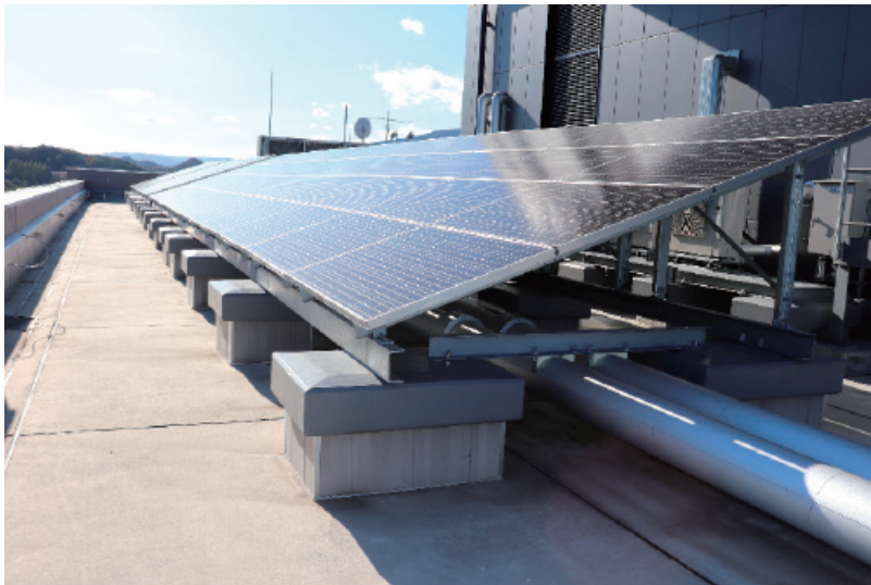
再生可能エネルギーの導入 (いわき市医療センター)
