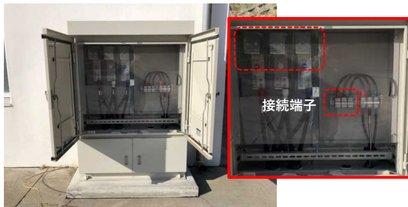
(再掲)図 36 非常用発電機接続用端子盤
