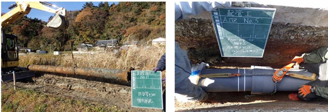
（左：老朽管の状況 右：耐震管布設の様子）
