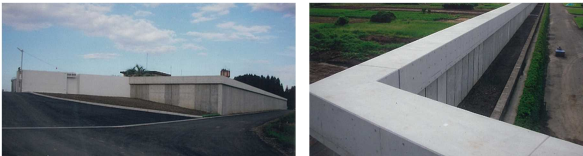
(写真提供：宮崎市水道局 富吉浄水場)
