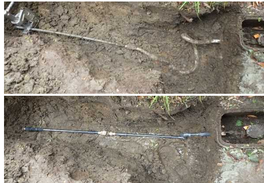
図 68 鉛製給水管の布設替えの状況(上:施工前 下:施工後)
