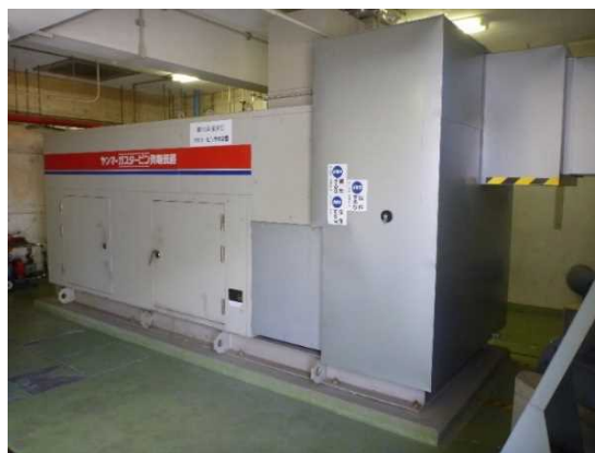
(再掲)図 35 上野原浄水場の非常用自家発電設備
