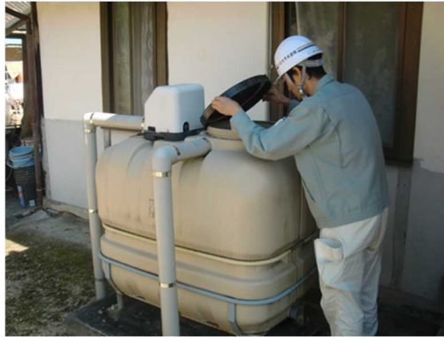
図 66 小規模貯水槽水道の点検の様子
