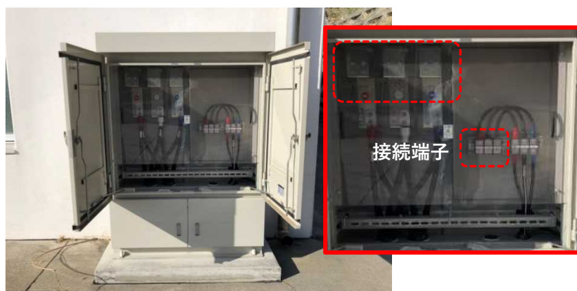
図 36 非常用発電機接続用端子盤
