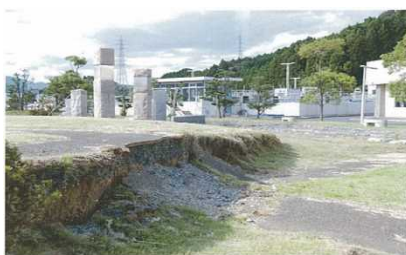
【敷地内の地盤沈下が発生した平浄水場】
