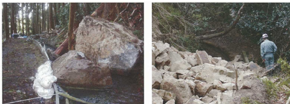
図 34 東日本大震災における大滝江筋用水路の被害状況
