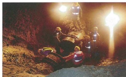
【山玉浄水場の \phi 800 mm 送水管の漏水修理】
