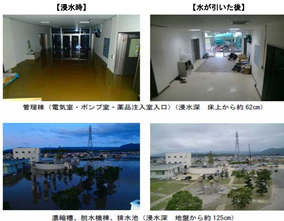
図 28 平浄水場の浸水状況
