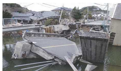
【津波による被害を受けた大平川横断配水管】
