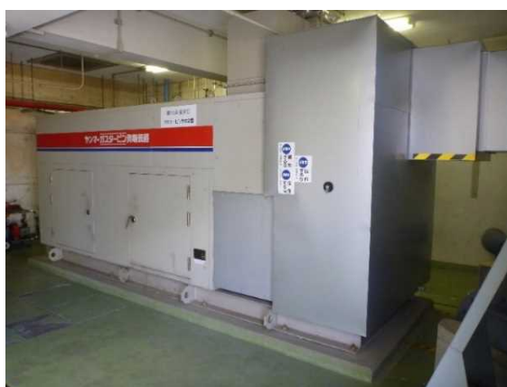
図 35 上野原浄水場の非常用自家発電設備
