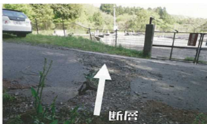
【断層による被害を受けた鷹ノ巣浄水場】
