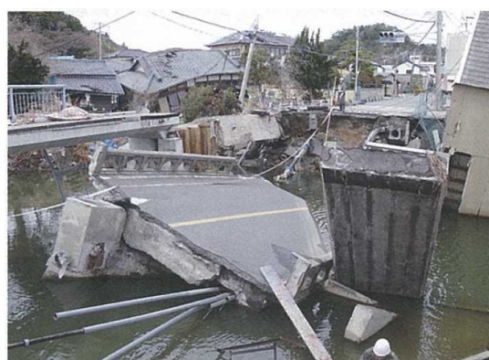
【津波による被害を受けた大平川横断配水管】
