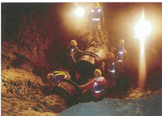
【山玉浄水場の送水管φ800 漏水修理の様子】
