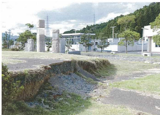
【敷地内で地盤沈下が発生した平浄水場】
