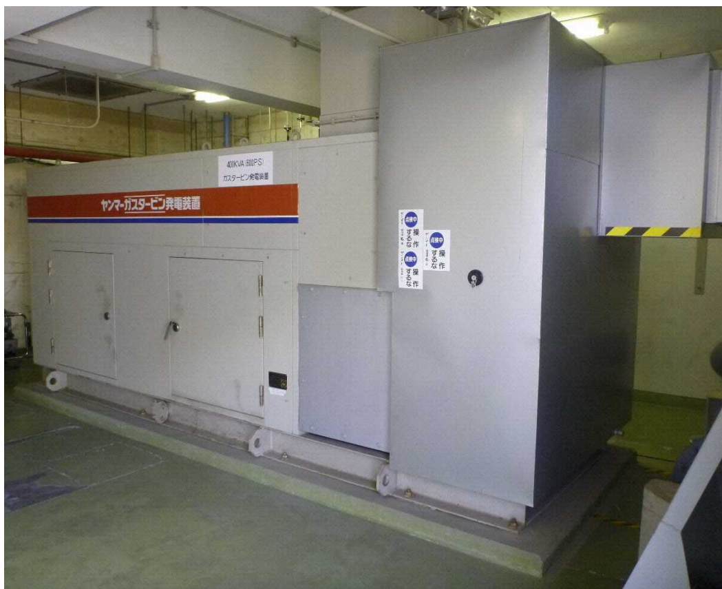
図 4-1 自家発電設備 (上野原浄水場)
