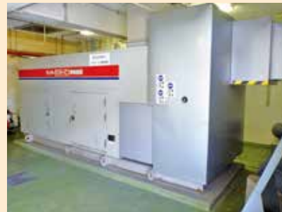
図 上野原浄水場の非常用自家発電設備
