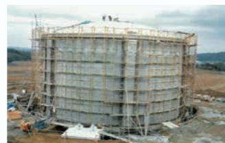
⑤法田配水池建設 (第二期拡張工事で完成)
