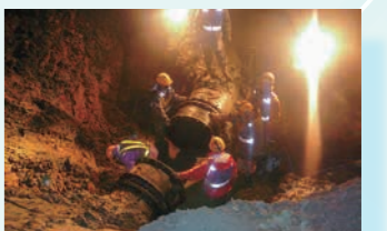
⑪復旧作業の様子 (山玉浄水場送水管)
