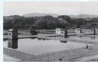
①上野原浄水場 (平町の給水のため整備)
