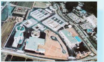
⑨平浄水場拡張後全景
