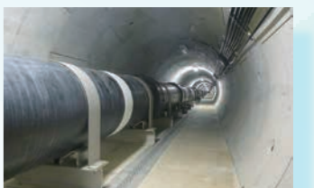
⑩夏井川幹線管路トンネル内の配水管
