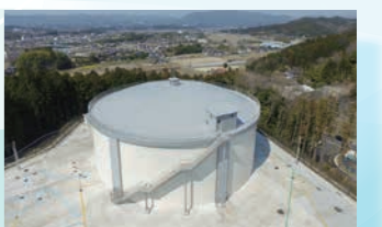
⑫平第二配水池
