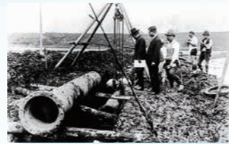
②配水管布設風景
