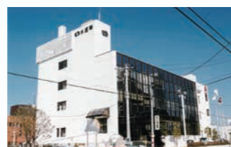
④水道局本庁舎
