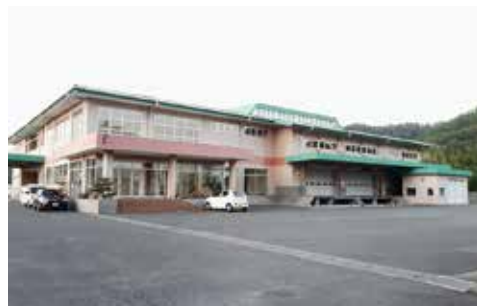
令和3年度から空調設備整備予定の小名浜学校給食共同調理場
