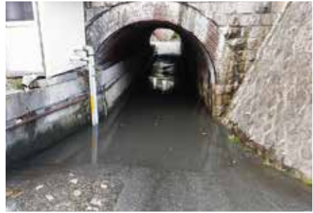
内郷御台境町新町前地内で発生した冠水の状況
