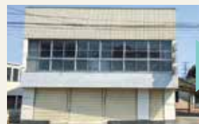
改修前(空き店舗)
