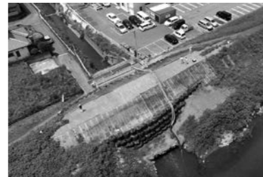
県の樋門設置と併せて排水施設整備を進める金子沢
