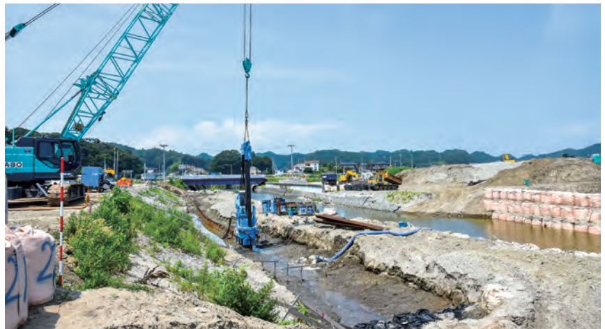
■写真 4-52 諏訪川の堤防かさ上げに着手・平豊間 〔平成 27(2015) 年 7 月 いわき市撮影〕
