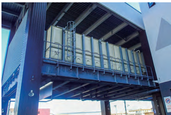
■写真 4-105 「イオンモールいわき小名浜」における緊急給水用受水槽 津波対策として 2 階に設置されている。〔平成 30(2018) 年 11 月 医療創生大学震災アーカイブ室撮影〕
