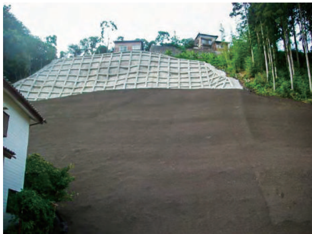
■写真 4-31 内郷内町駒谷地内のがけ崩れ・県災害関連緊急急傾斜地崩壊対策事業の施工後 [平成 24(2012)年 県いわき建設事務所撮影]
