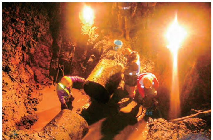
■写真4-14 山玉浄水場送水管の漏水修理 (平成23(2011)年3月 いわき市撮影)
