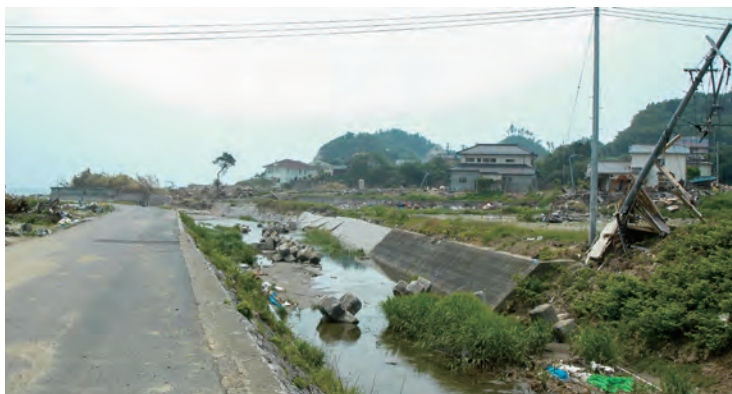
■写真 4-57 末続川流域の被害 海岸の波消しブロックが川中に転がっている。(平成 23(2011) 年 6 月 いわき市撮影)
