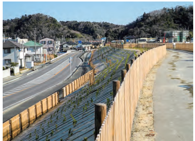
■写真 4-48 既設の道路や集落を守って設置された防潮堤かさ上げ、防災緑地の整備・永崎 [平成30(2018)2月 いわき市撮影]
