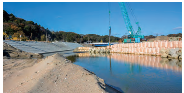
■写真 4-53 堤防かさ上げ工事が進む諏訪川・平豊間 〔平成 27(2015) 年 12 月 いわき市撮影〕
