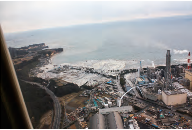
■写真 1-1 津波が押し寄せる岩間海岸と常磐共同火力勿来発電所（平成 23(2011)年 3月 11 日午後 3時 46分 県消防防災航空隊提供）
