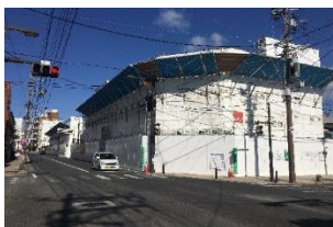
写真：解体が進む市営天王崎団地
