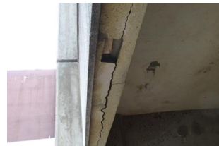
写真：公共施設に入った亀裂
