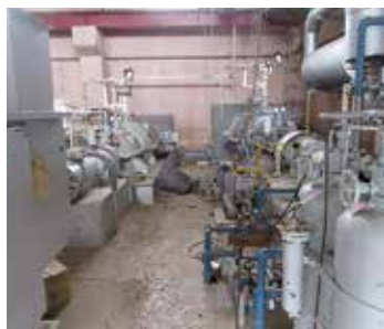
中塩排水機場の内部
