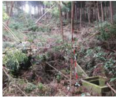
小川市民運動場の被害箇所
