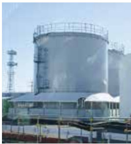
多核種除去設備等処理水貯蔵タンク
