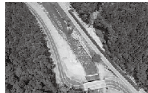
仮設道路の整備が完了した国道289号
