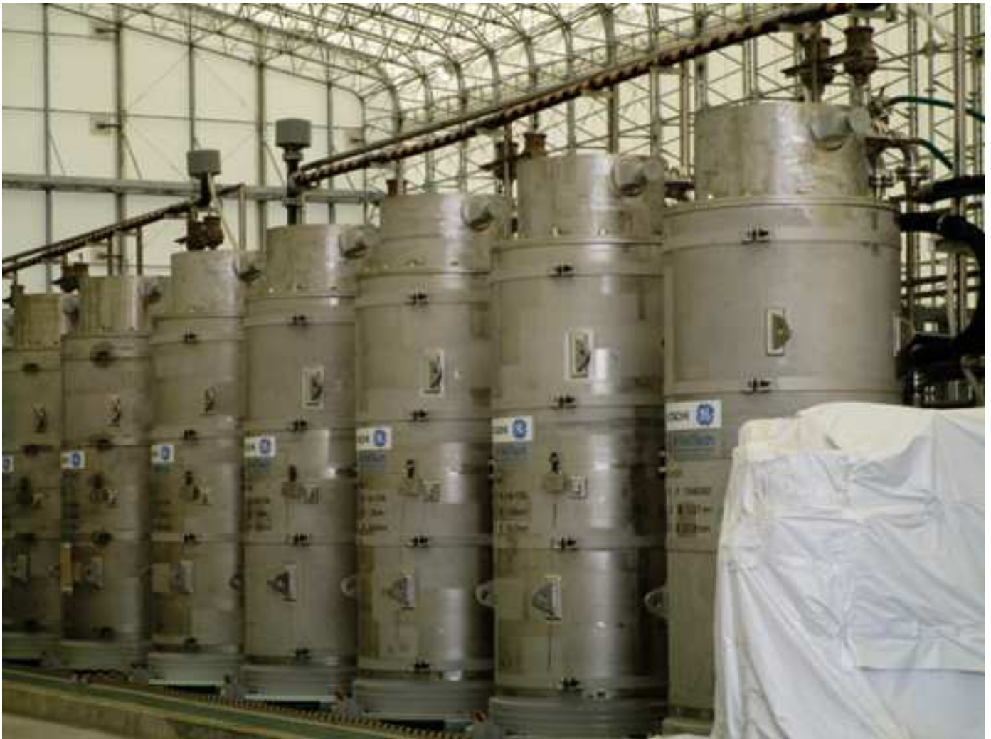
「多核種除去設備（ALPS）」
