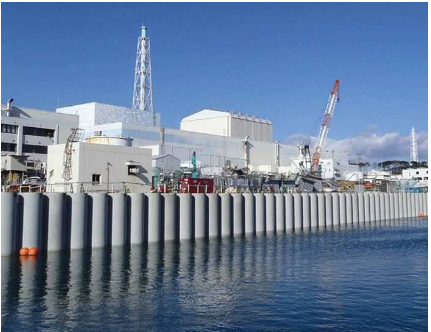
東京電力福島第一原子力発電所の海側遮水壁（しゃすいへき）
