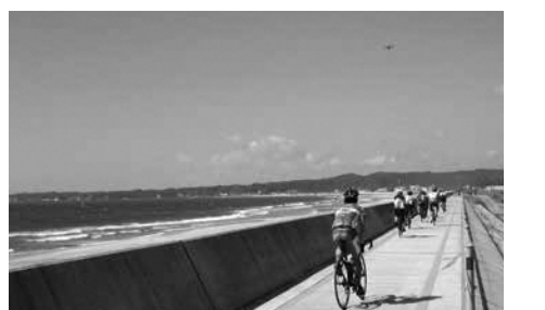
一部区間で供用を開始したいわき七浜海道
