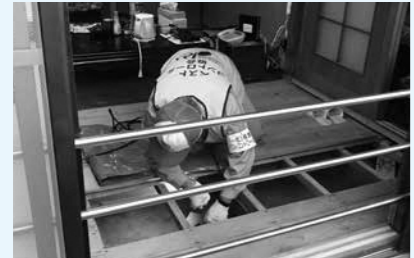
浸水被害のあった地区で実施している床下消毒
