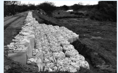
応急復旧で土のうが積み上げられた河川の決壊箇所
