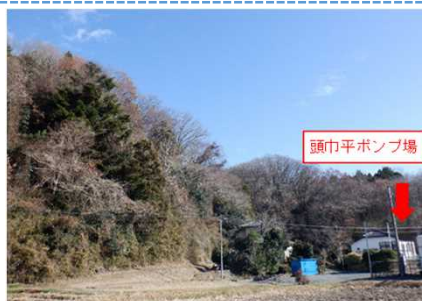
図 頭巾平ポンプ場 現地調査写真
