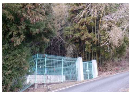
図 下ヶ屋敷調整池 現地調査写真
