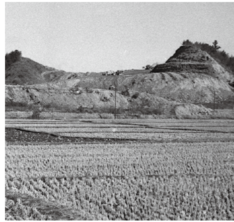
造成が進む萱手営農団地 [昭和46 (1971)年2月 いわき市撮影]
