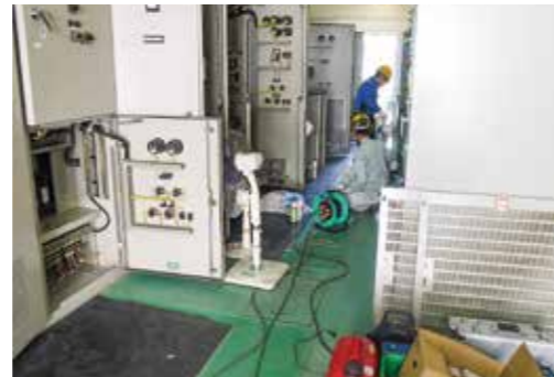
洗浄と乾燥を行う受電設備（平浄水場）
