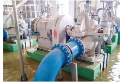
水がひいてきたポンプ室（平浄水場）
