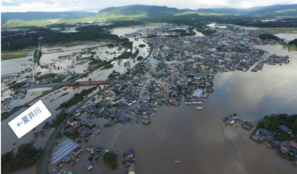
【令和元年10月 台風第19号による浸水被害状況】(二級河川夏井川 平下平窪地区)
