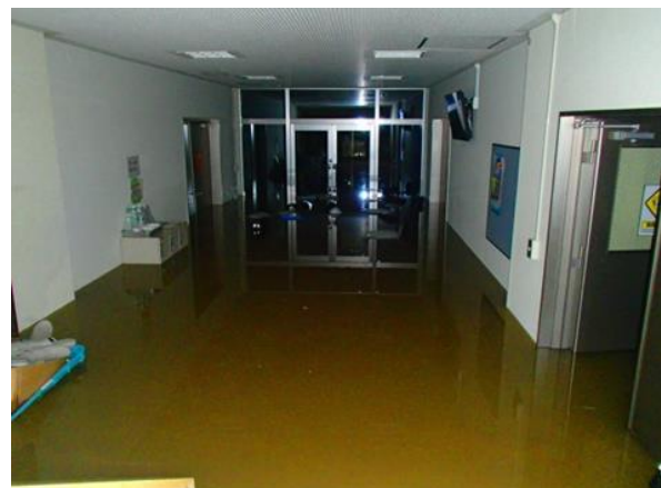
【平浄水場管理棟浸水状況（床上約 60 cm）】
