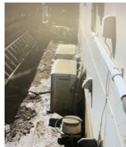
エアコン室外機 制御基板、ファンモーターの故障
