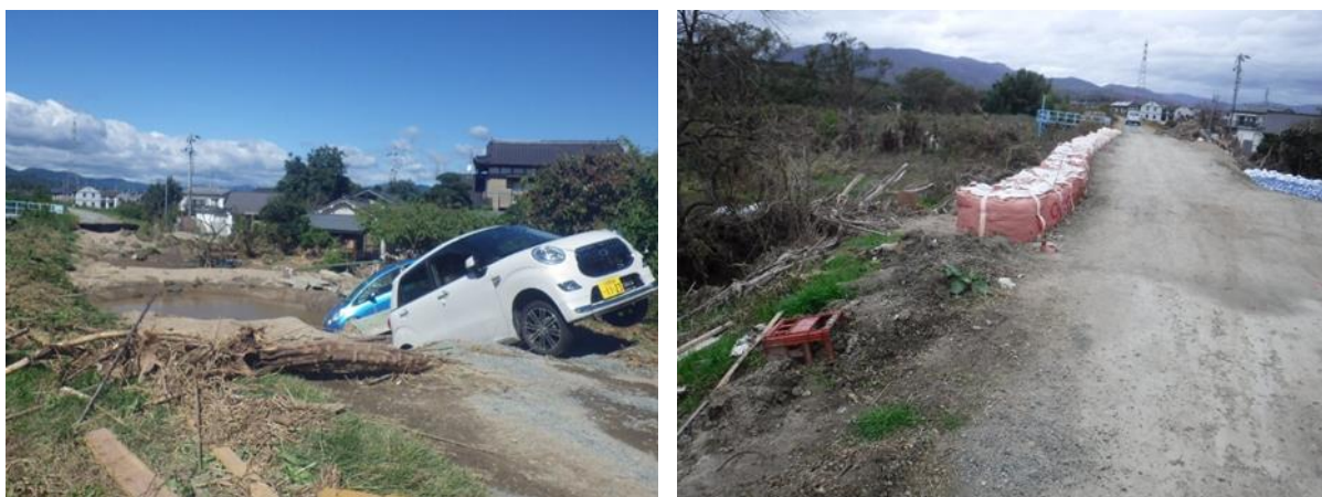
【令和元年10月 台風第19号による堤防決壊・仮復旧状況】(二級河川夏井川 平下平窪地区)
