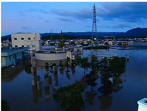
【平浄水場浸水状況】
