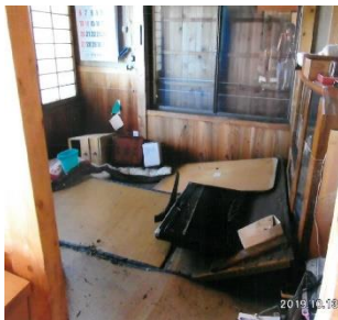
■ 悪臭・汚れ、折れ曲がり
