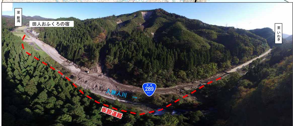
【令和元年10月 国道289号被災状況】 延長約800mにわたり約4,000m 3 の土砂が堆積(田人町旅人地区)
