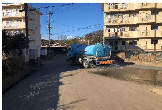
<路面散水(清掃)>
