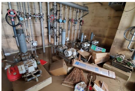
<農業集落排水処理施設>
