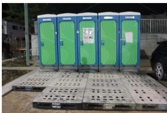
<仮設トイレの設置>
