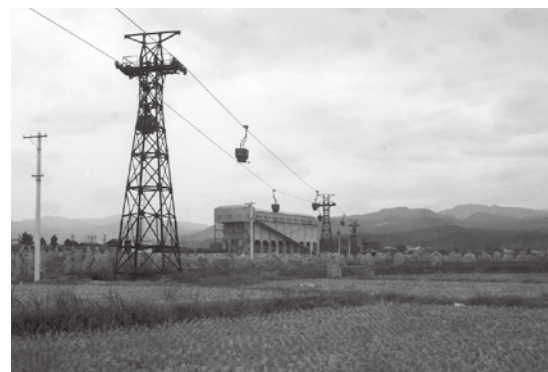
小川町高萩、三島地区の風景。粘土輸送の架空索道が敷設されていた〔昭和42（1967）年10月 いわき市撮影〕
