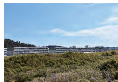
県復興公営住宅（北好間団地）
