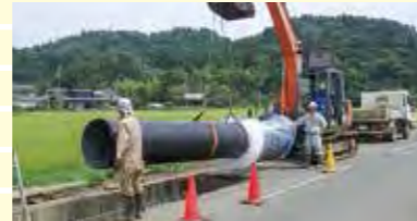
地震に強い水道管への取替え工事
