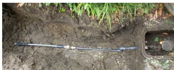
鉛製給水管の布設替えの状況
