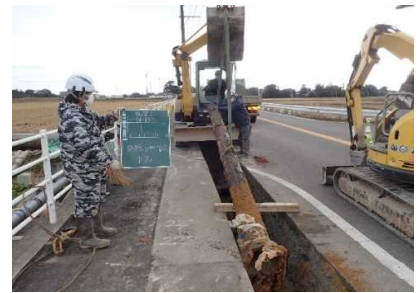
配水管の改良工事の様子
