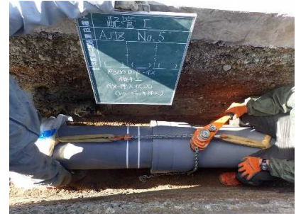
耐震管(GX形)布設の様子
