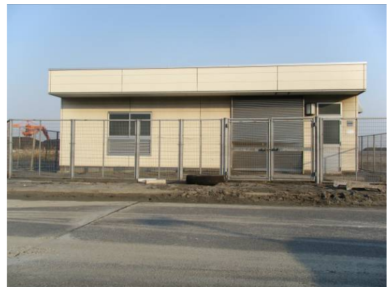
分岐施設（電源設備）
