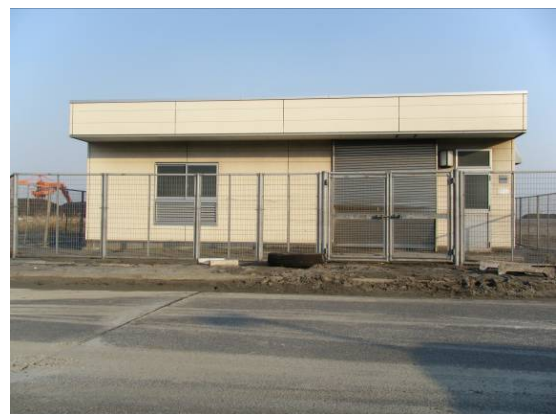
分岐施設（電源設備）
