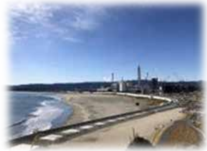
建設中の石炭ガス化複合発電（IGCC）と防災緑地
