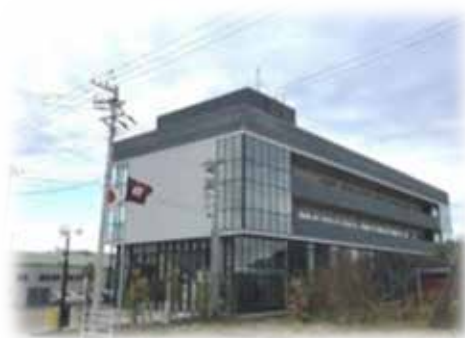
いわき市地域防災交流センター 久之浜・大久ふれあい館
