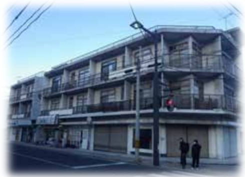
老朽化している公共施設
