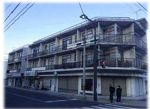
老朽化している公共施設 出典：市撮影
