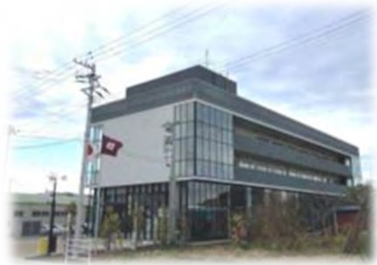
市地域防災交流センター久之浜・大久ふれあい館
