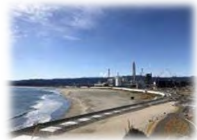
建設中の IGCC と防災緑地
