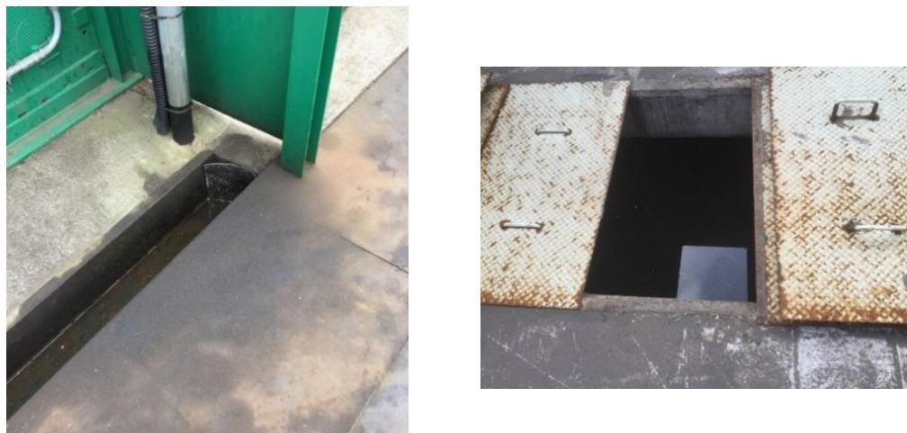
(左：ヤード周辺に排水溝を設置、右：油水分離槽の設置)
