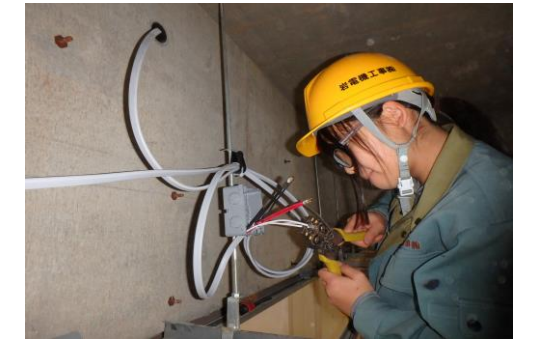
【公共施設電気工事での配線作業】
