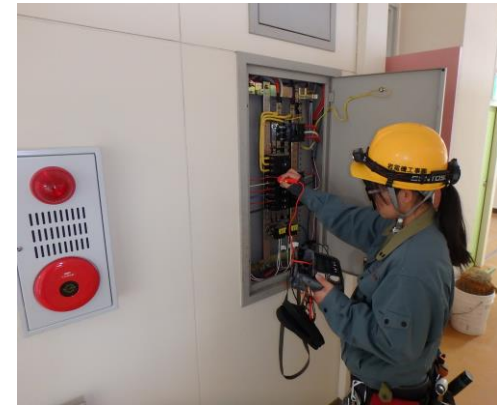
【公共施設電気工事での最終確認】
