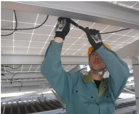
【太陽光発電施設電気工事での配線作業】
