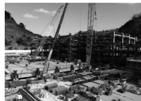
来年12月の開院を目指して工事を進める新病院
