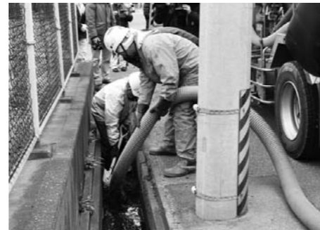
3月に実施した側溝堆積物撤去のモデル事業
