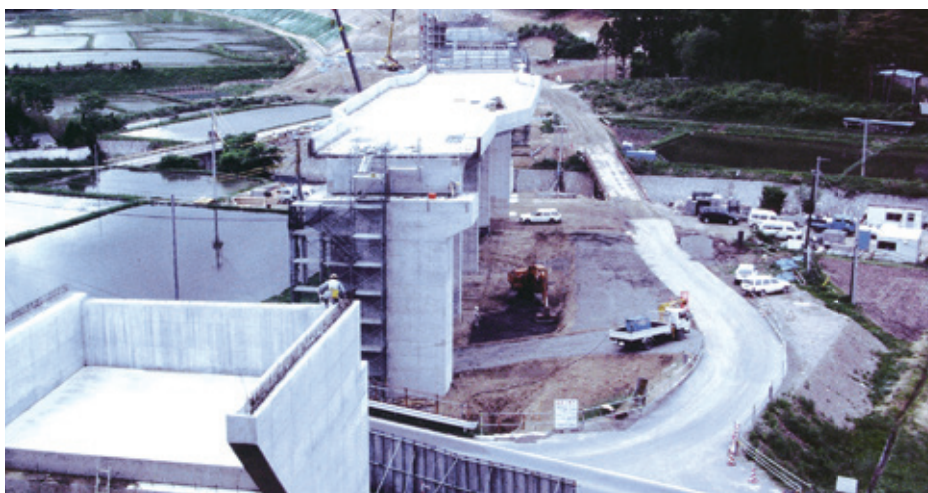
磐越自動車道渡戸橋付近の工事
