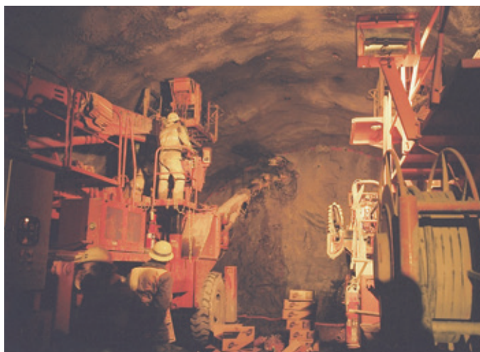
磐越自動車道トンネル工事
