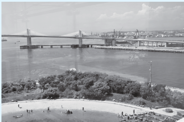
〈写真2〉アクアマリンふくしまから見る3号ふ頭と東港に架かる橋 [平成28(2016)年8月、いわき市撮影]
