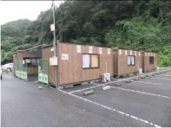
ペット保護センターの外観
